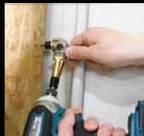
○壁際での作業
